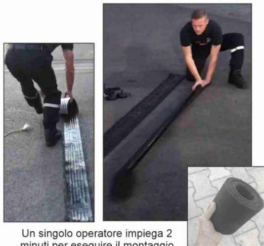
Un singolo operatore impiega 2 minuti per eseguire il montaggio
