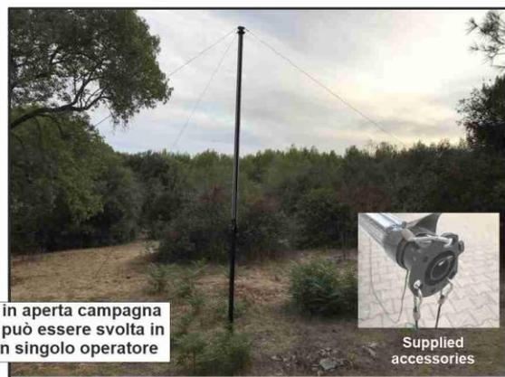
L'installazione in aperta campagna tramite tiranti può essere svolta in 5 minuti da un singolo operatore
