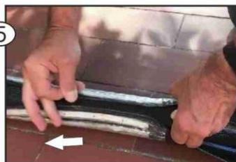
La tecnica consiste nell'utilizzare la stessa mano sia per mantenere il manicotto in pressione attorno alla colonna sia per afferrare la cerniera e iniziare a chiudere.
