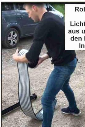
Rollen Sie die LED-Lichtmanschette aus und legen Sie den Mast auf die Innenseite.
