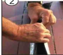
... Anschließend die Manschette fest gegen den Mast drücken und mit derselben Hand den Reißverschluss greifen, während die andere Hand auf den Verschluss
