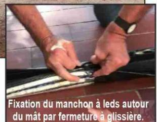
Fixation du manchon à leds autour du mât par fermeture à glissière.
