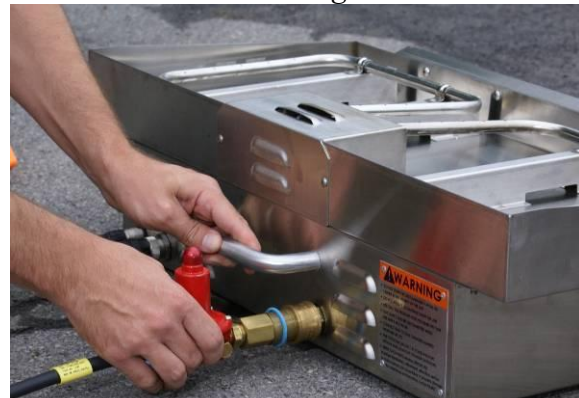
Image 5 : extrémité QD du tuyau à propane
